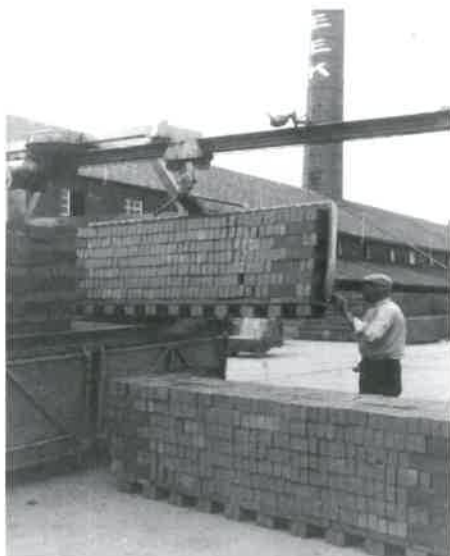
Verwerken Milsbeker strengpers-steen, machinaal en handmatig (bron Stichting Cultuurbehoud Milsbeek)
