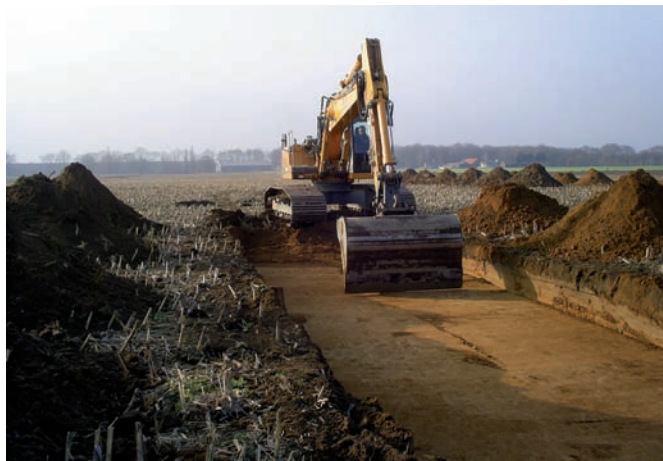
Afb. 1. Het aanleggen van een put.
