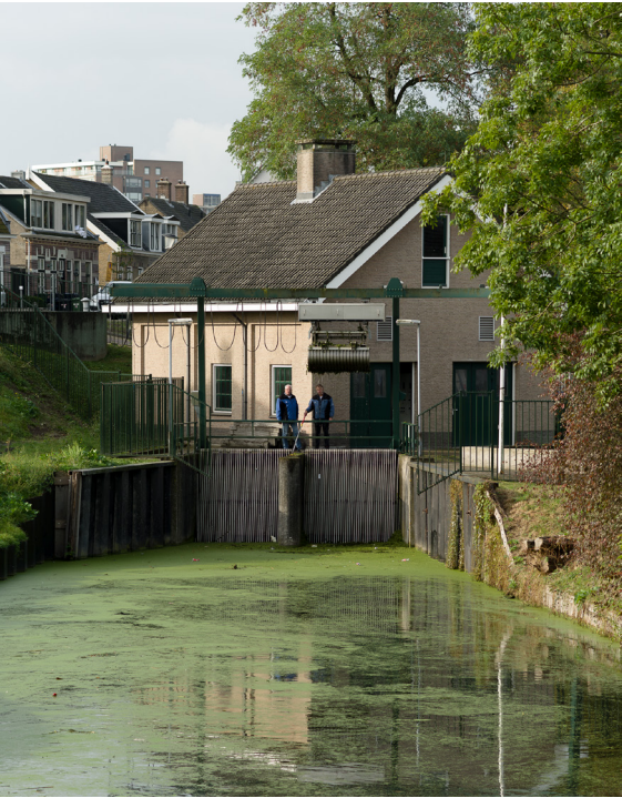
Onderhoudswerkzaamheden bij het gemaal aan de Schielands Hoge Zeedijk in Capelle aan de IJssel.
