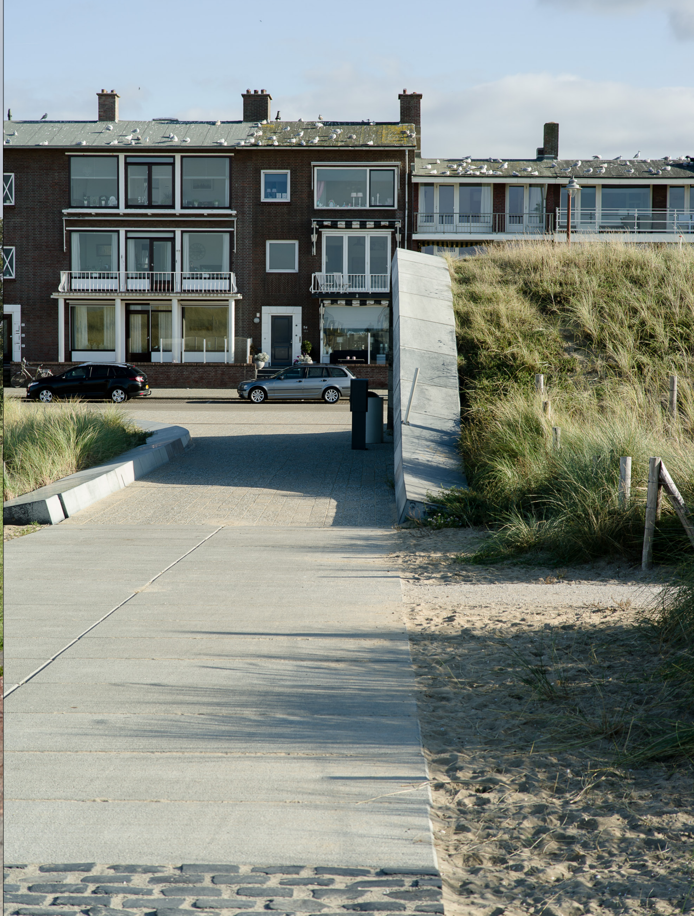
Bebouwing aan de boulevard bij Kustwerk Katwijk.
