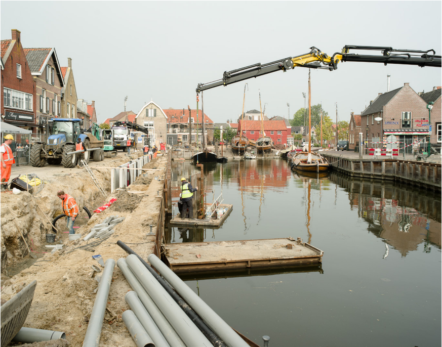
Aanleg van de zelfoprijvende kering in Spakenburg.
