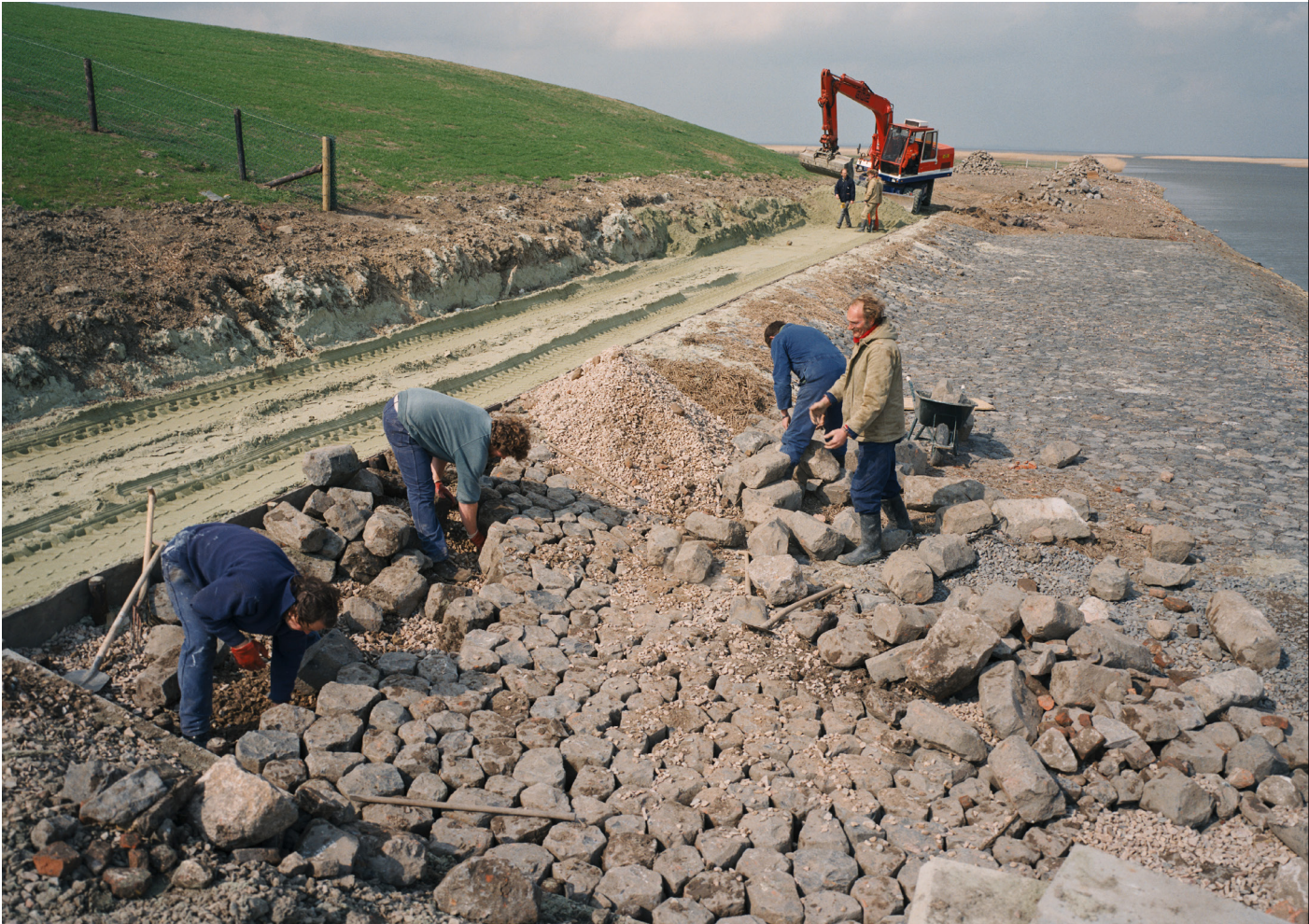
Herzetten van een steenbekleding, 1991.
