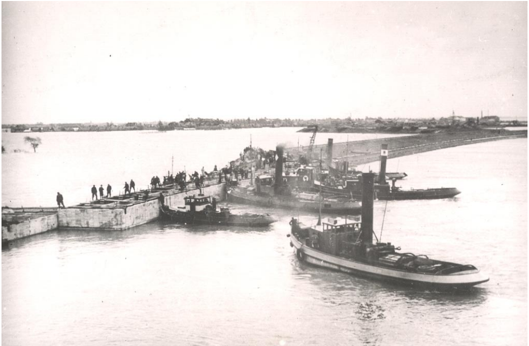
Mei 1953: sluting van een dijkgat nabij Kruieningen met behulp van caissons
