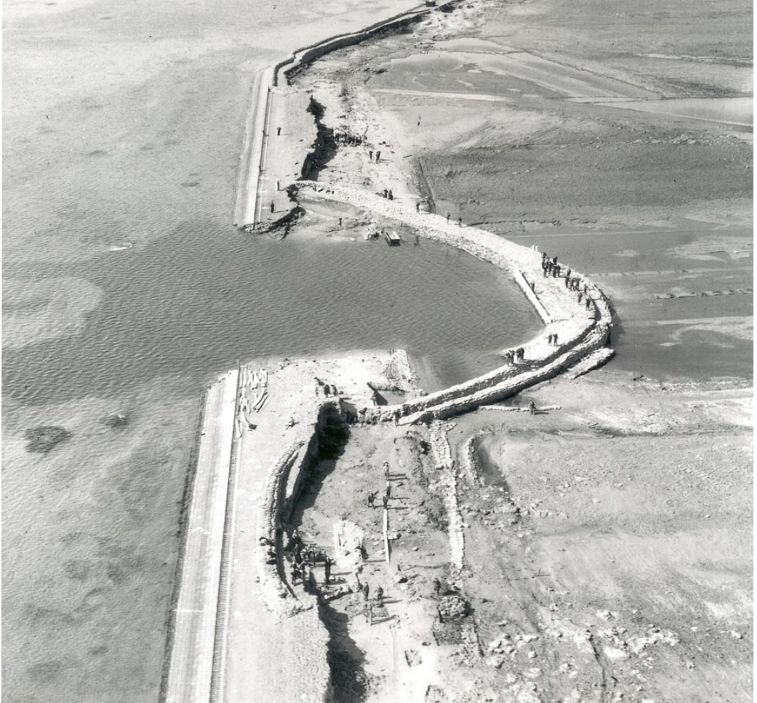
Sluting van het stroomgat. duidelijk is te zien dat de oorzaak van de dijkbraak overslaand water was. Het buitentalud is veelal onbeschadigd
